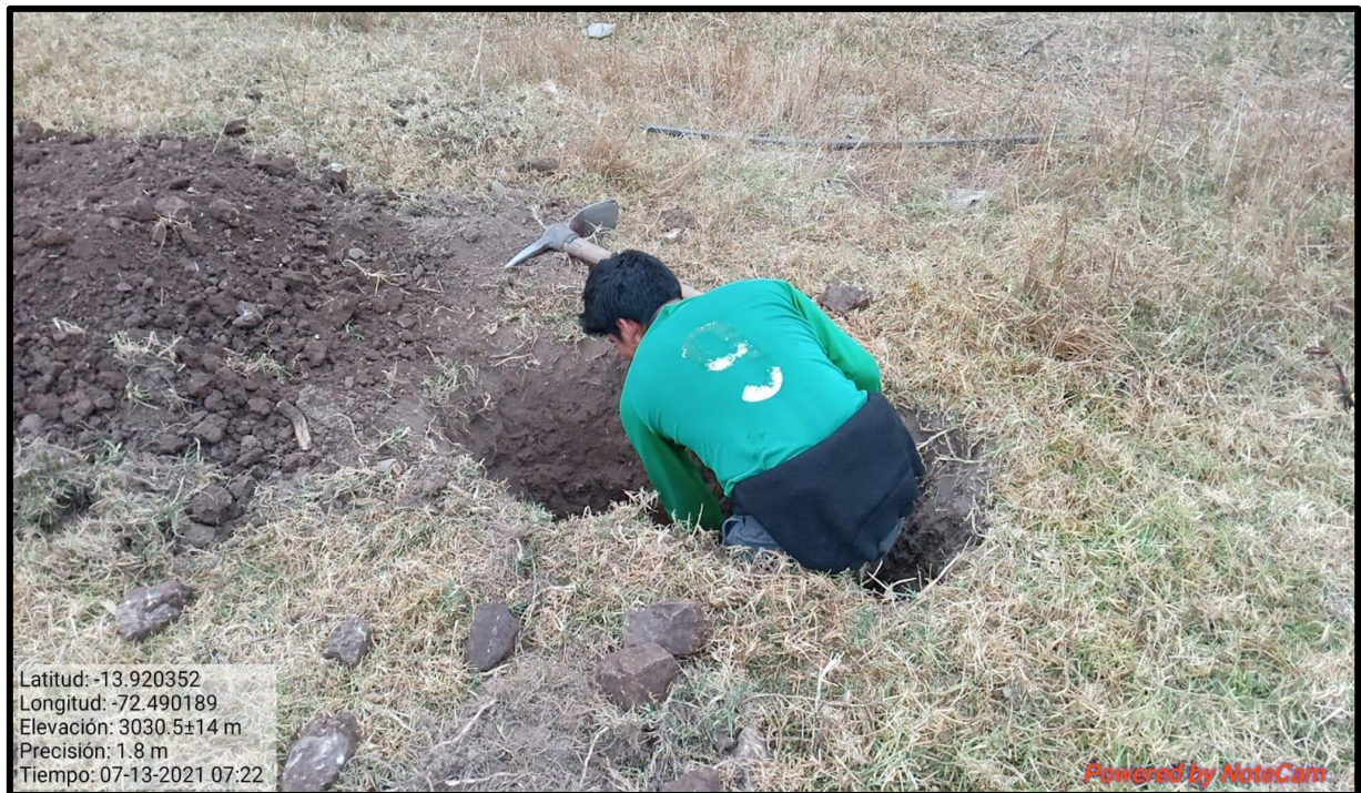
Figura 32—Apertura de calicatas
