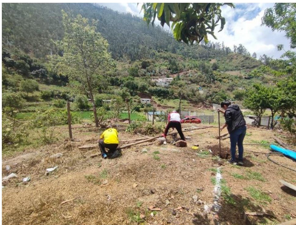
Figura 16 — Apertura de hoyos
