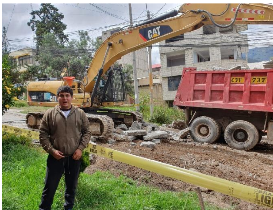
Figura 99 — Recolección de escombros de concreto
