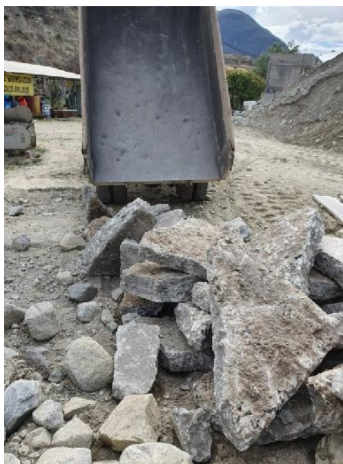
Figura 101 — Almacenamiento de los escombros de concreto
