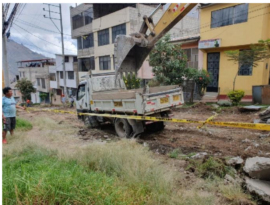
Figura 102 — Traslado de los escombros de concreto
