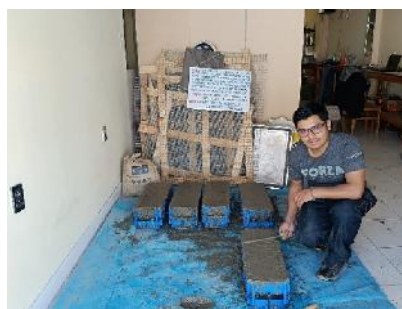
Figura 43 — Elaboración de viguetas de concreto
