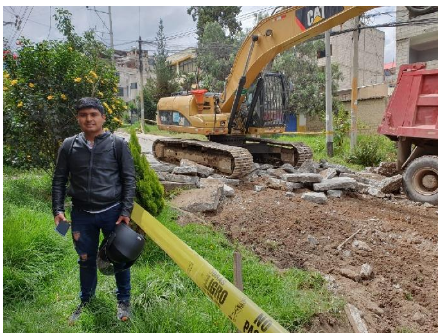
Figura 100 — Recolección de escombros de concreto
