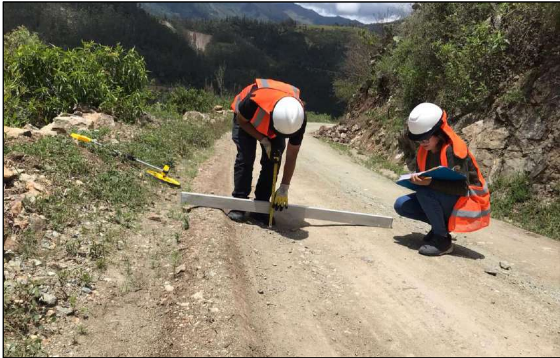
Figura 80 — Medicion de fallas de ahurllamientos para el analisis con la metodologia URCI
