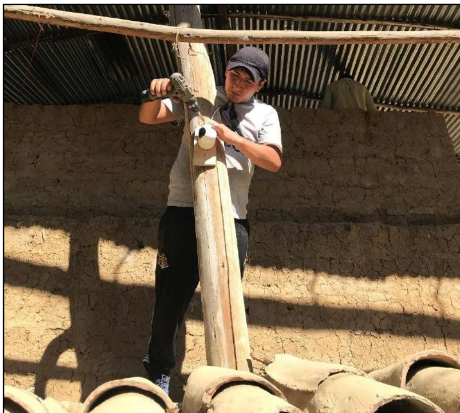
Figura 76 — Colocacion de la camara de seguridad en la vía 2
