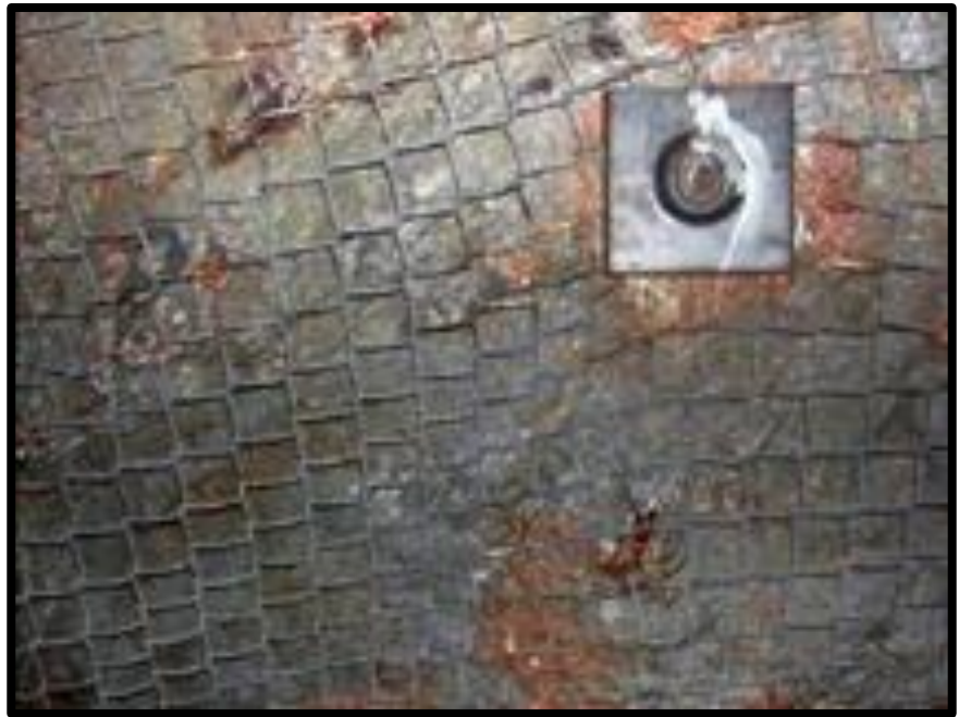
Figura 18 — Malla eslabonada en excavación
