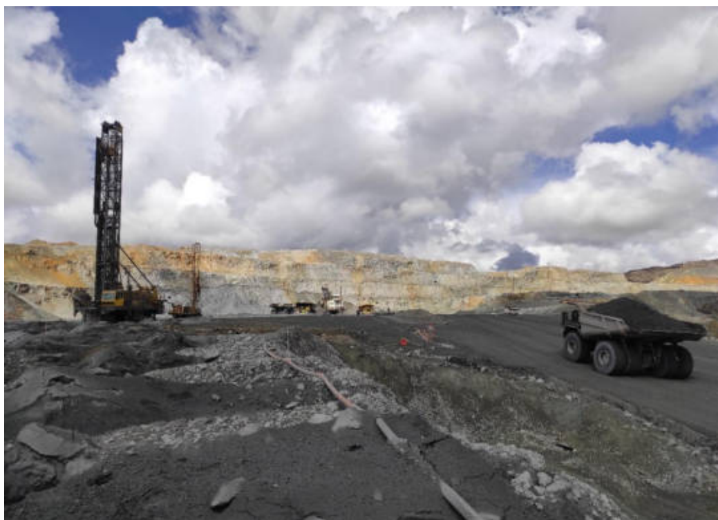
Figura 50 — Vista panorámica de equipos de perforación y carguío
