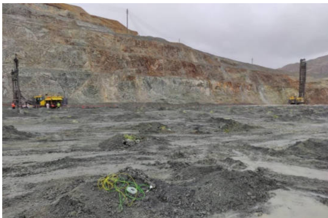
Figura 49 — Taladros cargados con mezcla explosiva Quantex 73
