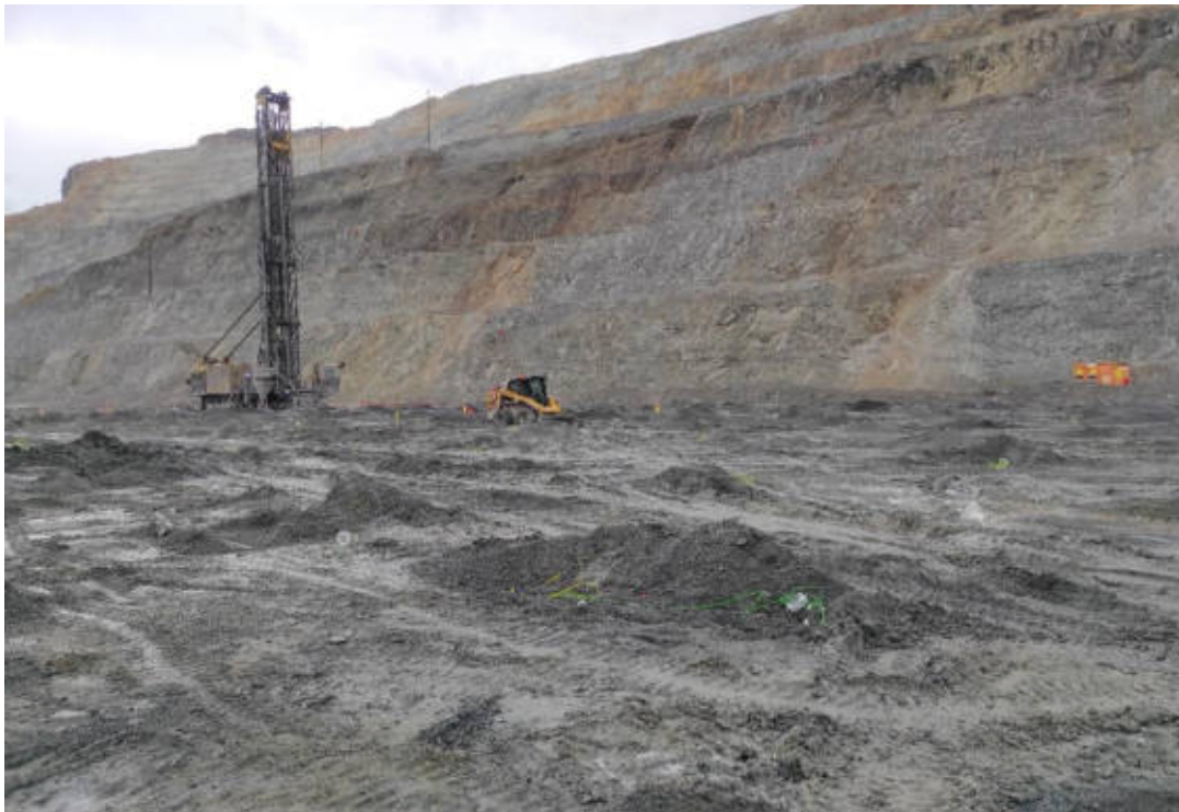
Figura 44 — Taladros con sus respectivos accesorios de voladura
