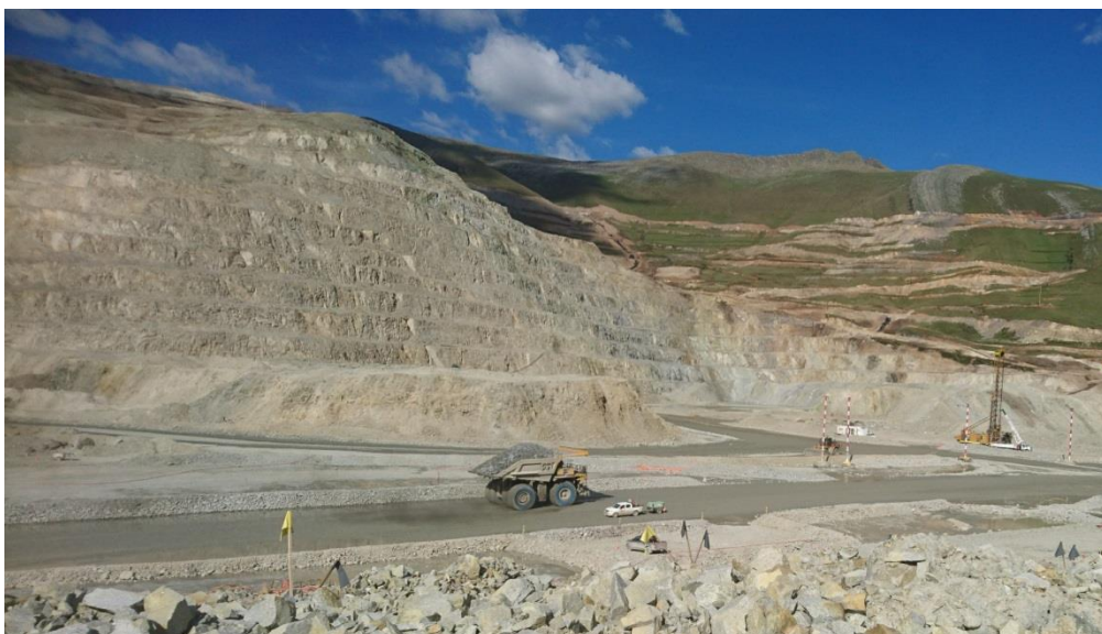
Figura 4: Acarreo de material
