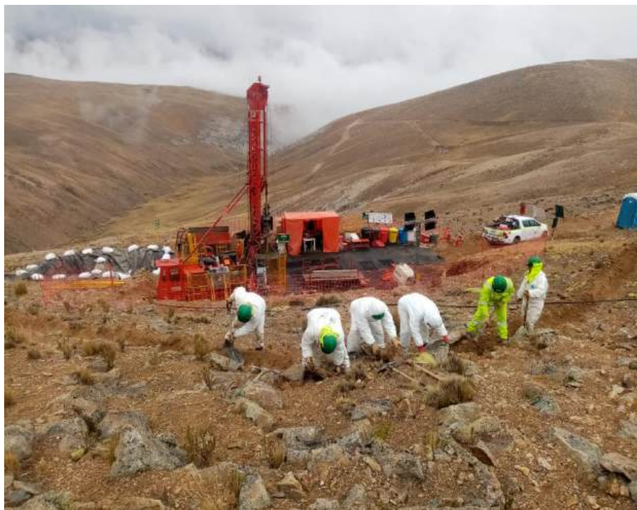
Figura 18 — Habilitación de canal de coronación.
