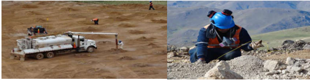
Fotografía 15. Se aprecia el carguío de taladros
