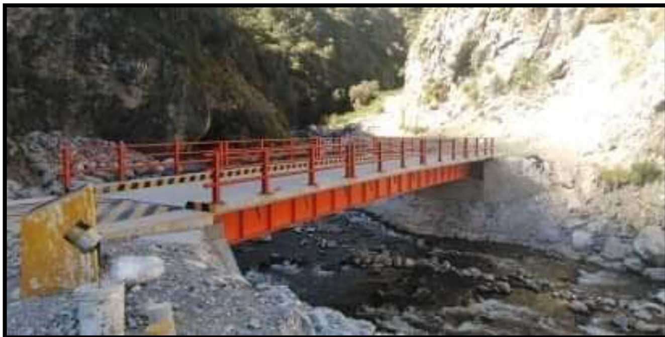
FOTOGRAFIA N°31 , Construcción del Puente Chicnilla en el Distrito de Huaquirca
