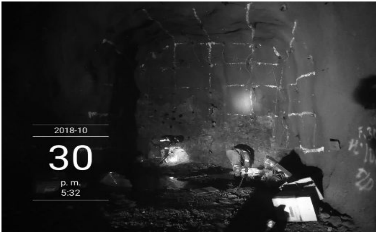
Imagen 2: Sección 4.5mx 4.5m donde se evidencia el carguío de frente con RMR 45
