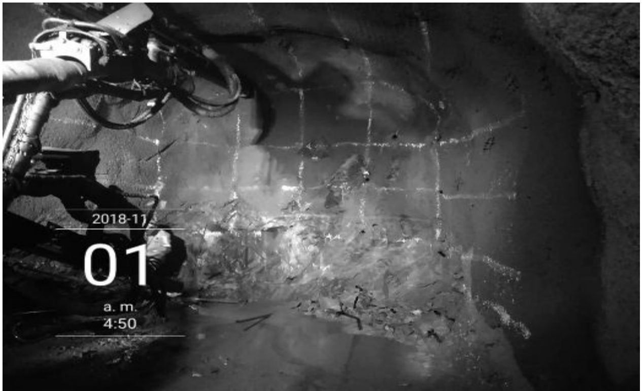
Imagen 1: Jumbo de dos brazos realizando la perforación de un frente de 4.5m x 4.5m con RMR 32
