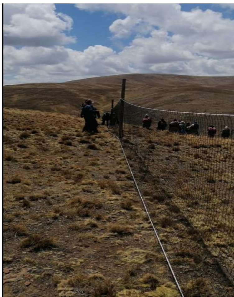
Figura 3: Colocación de cercos de malla. (Se observa cómo se ponen mallas provisionales para evitar la fuga de las vicuñas).
