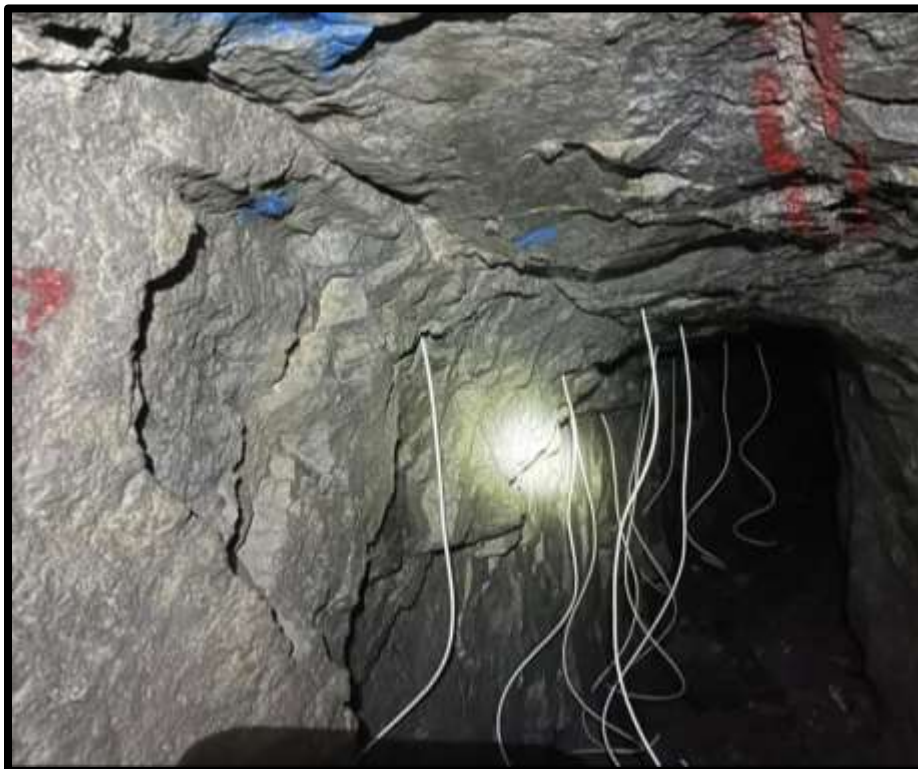
Figura 48 — Cargado de taladros en el tajeo
