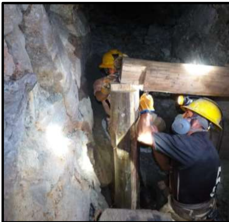
FUENTE: Compañía Minera Sol de los Andes, 2024 Figura 20 — Sostenimiento con cuadros de madera
