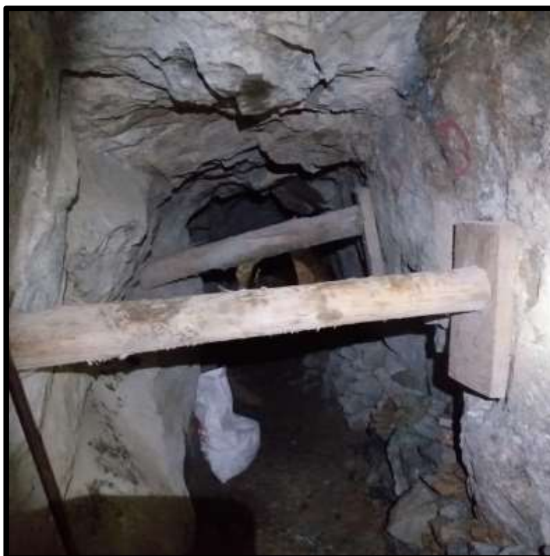
FUENTE: Compañía Minera Sol de los Andes, 2024 Figura 21 — Sostenimiento con puntales
