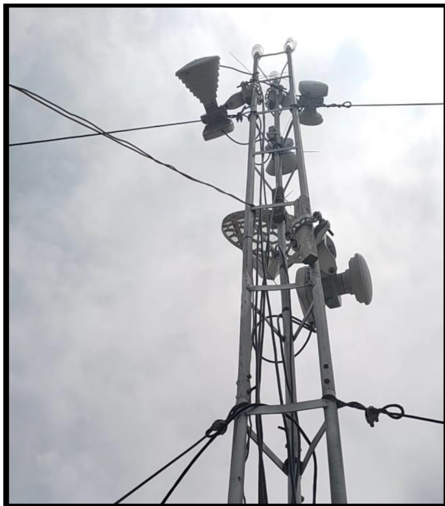
Figura 35 — Instalación de la torre principal
