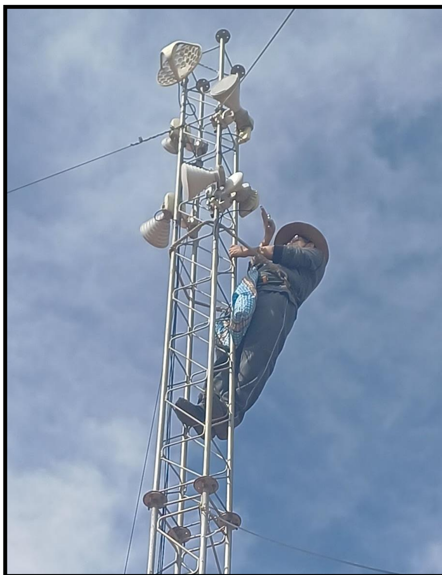
Figura 39 — Colocación de las antenas y equipos
