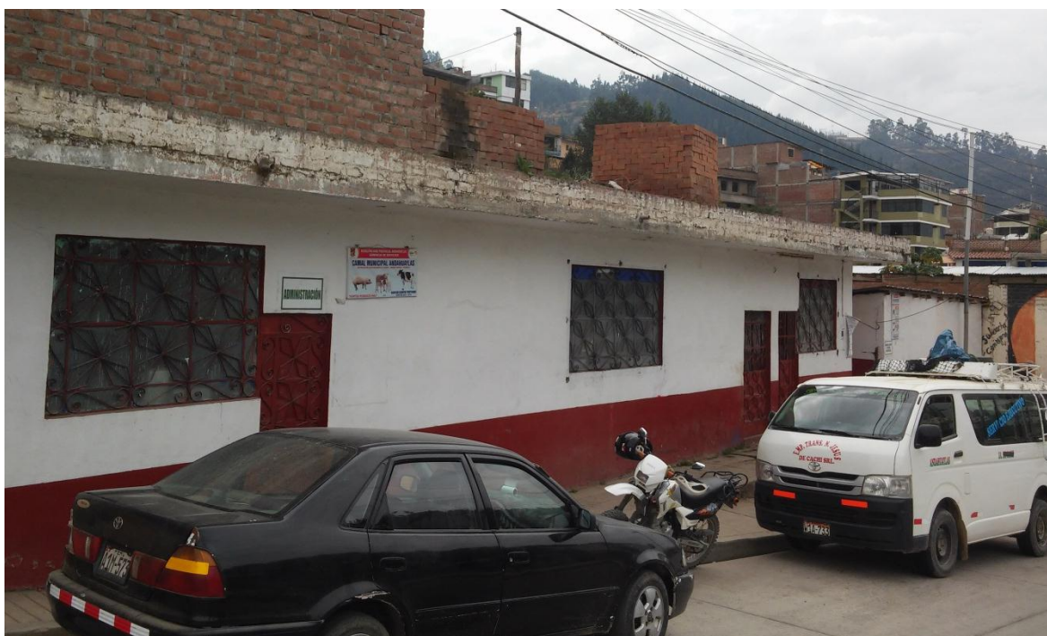
Imagen 02. Matadero Municipal del distrito de Andahuaylas.
