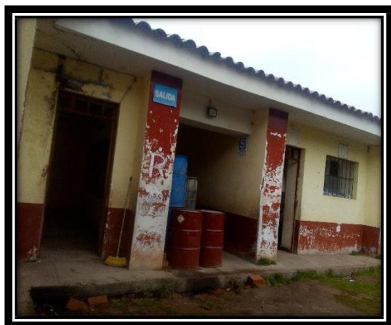
Imagen N° 03: Ambiente de trabajo de las oficinas de equipo técnico de infraestructura
