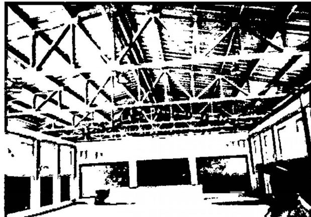
Almacén para productores de fibra de alpaca de la comunidad de San Miguel de Mestizas-Cotaruse-
