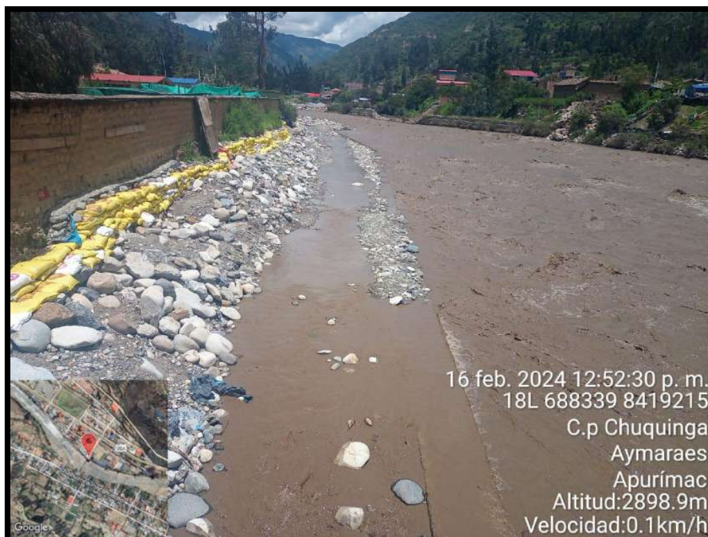
Figura 67 — Medición de ancho del río Chalhuanca.
