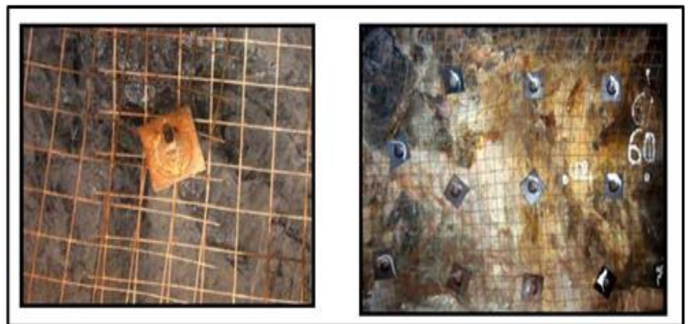
Figura 20 — Malla electrosoldada
