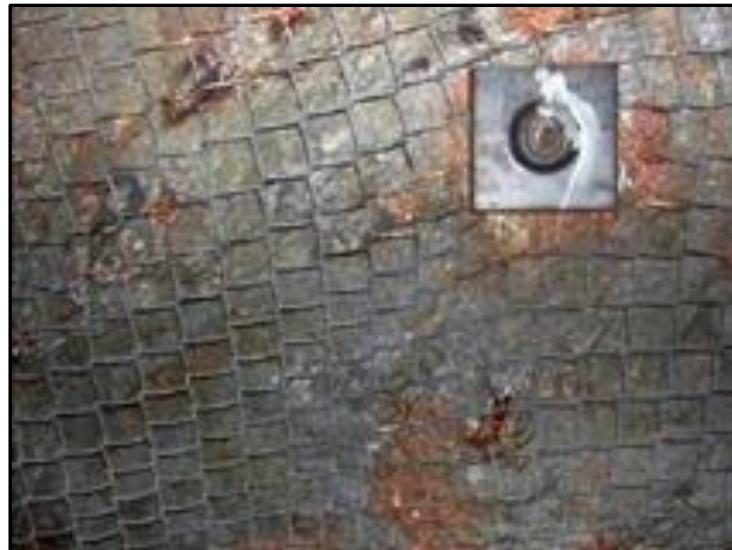
Figura 19 — Malla esbalonada en excavación
