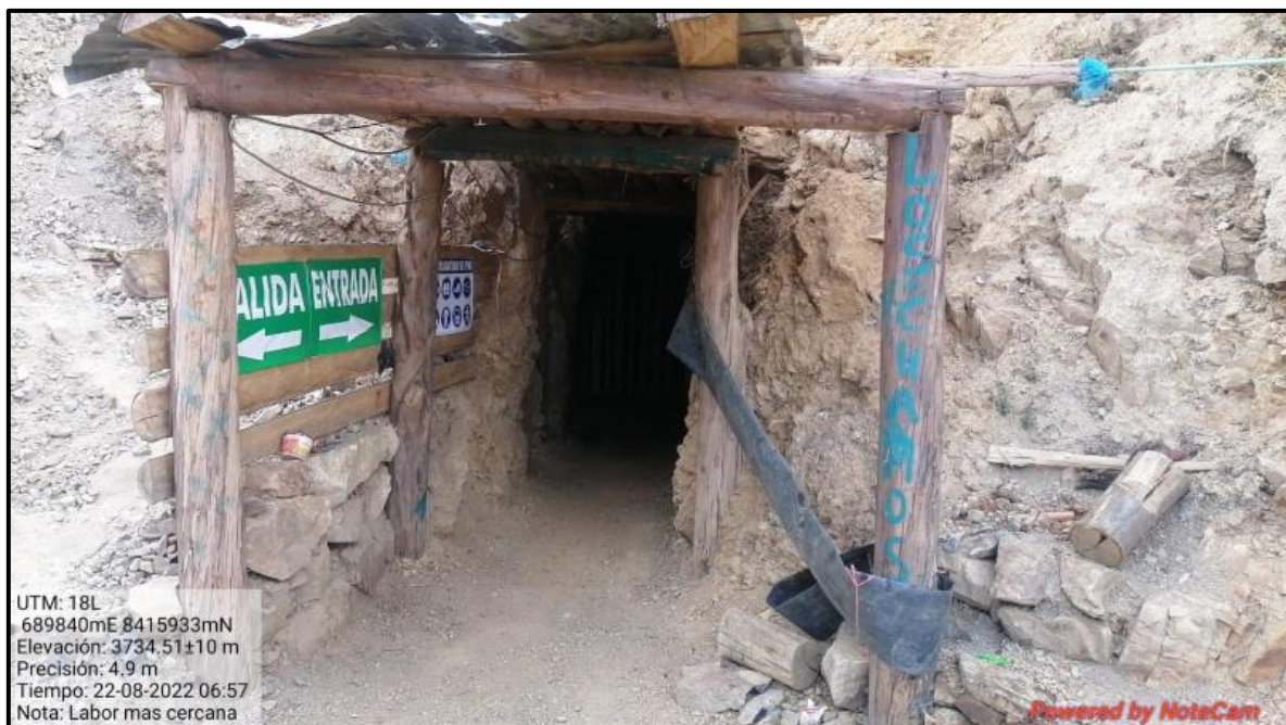
Figura 38— Identificación del sostenimiento actual de la galería
