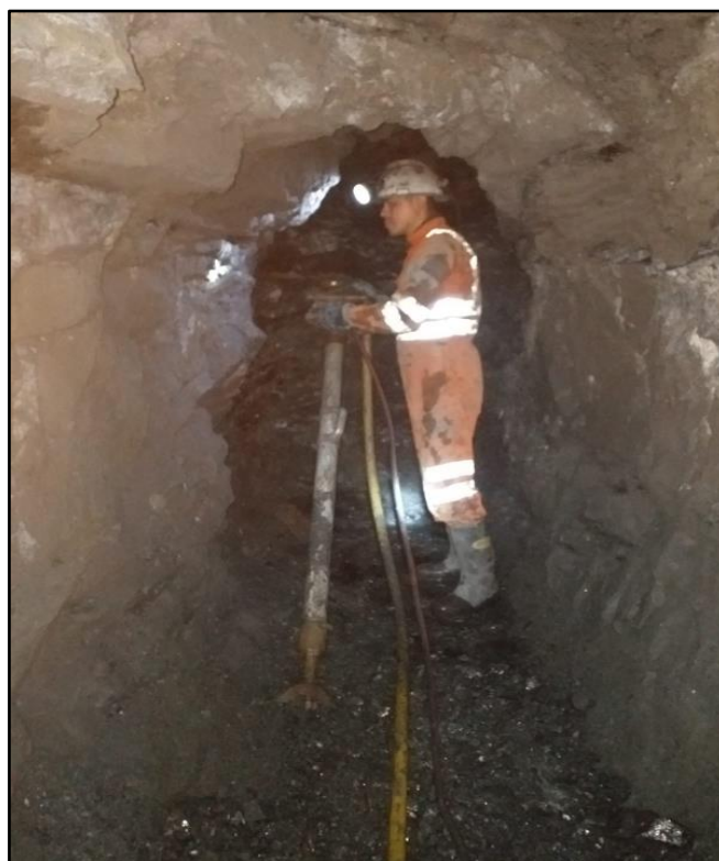
Figura 42 — Reconocimiento de roca para realizar el ensayo correspondiente en una labor subterránea
