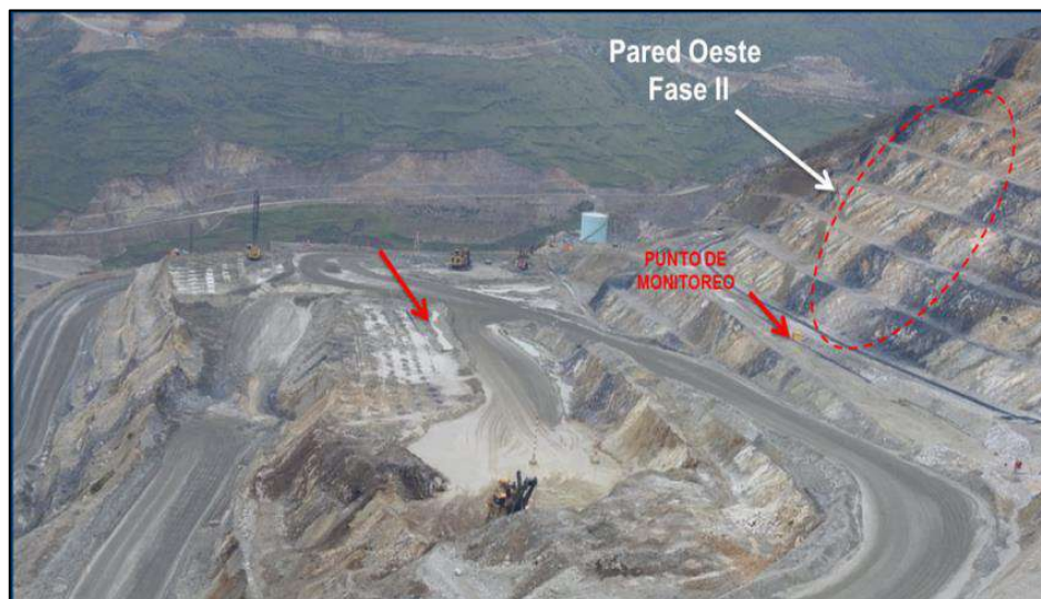
Fotografía 20: Ubicación de falla en zona de fase II. Fuente: Asistencia técnica Orica - Las Bambas.
