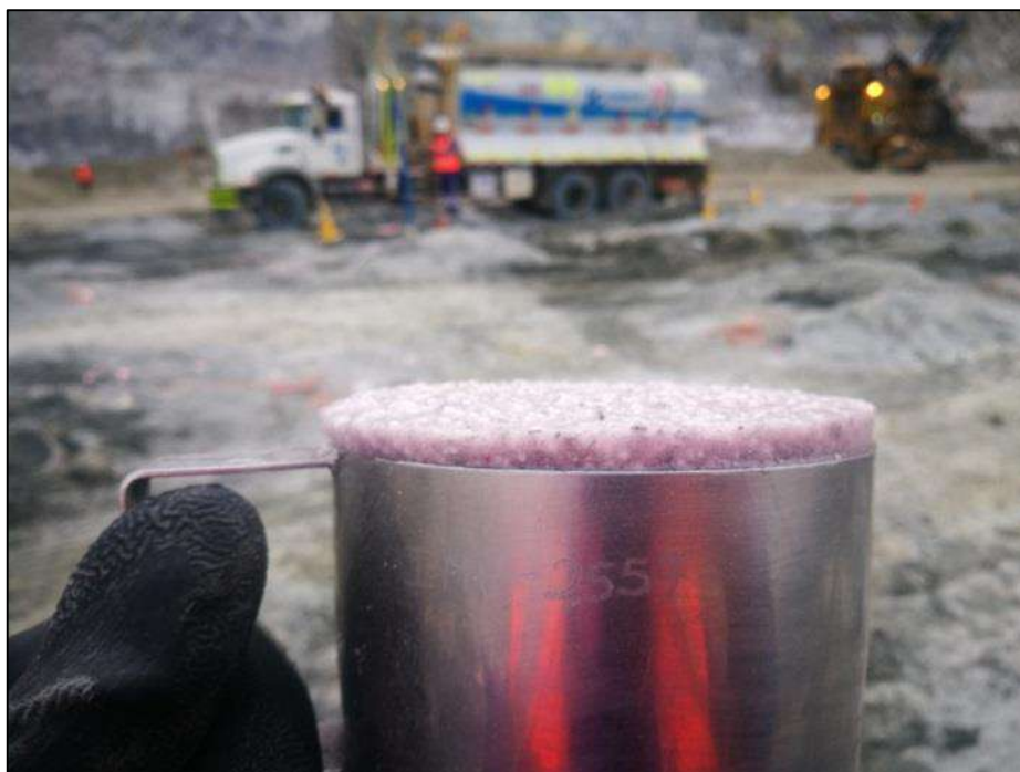
Fotografía 5: Proceso de gasificación de la mezcla en el Proyecto 3885_15. Fuente: Propia.
