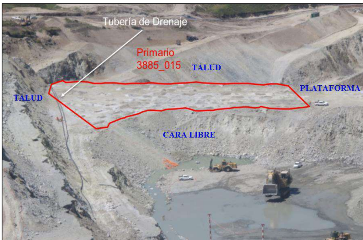
Fotografía 4: Malla de perforación del proyecto 3885_015.
