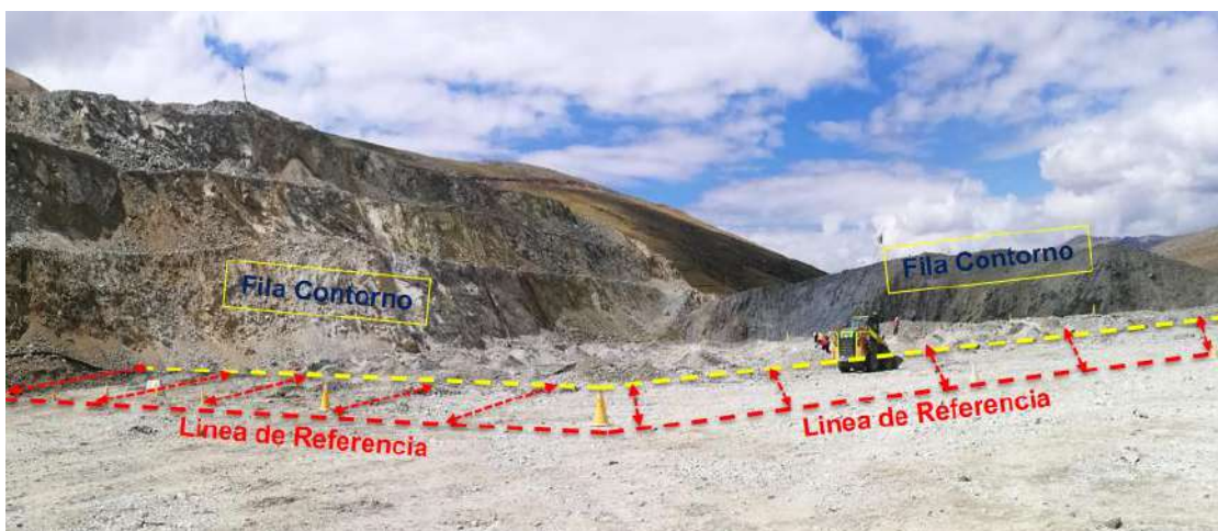
Fotografía 17: Línea de referencia a lo largo de la plataforma para el estudio del sobrequebre del proyecto 3870-09-011.
