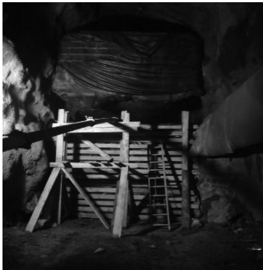
Fotografía N° 5: Vista panorámica de un encofrado terminado.
