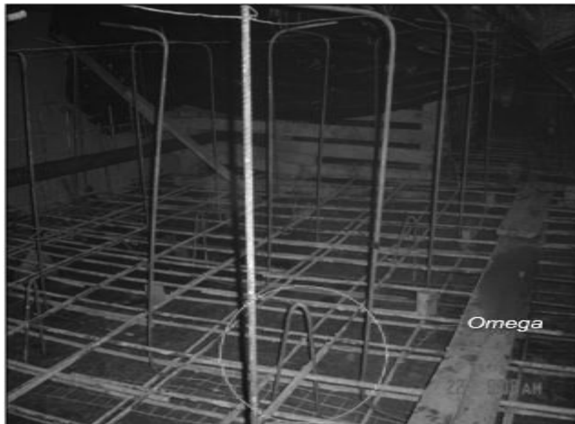
Figura N°3.15: colocado de “omegas”
