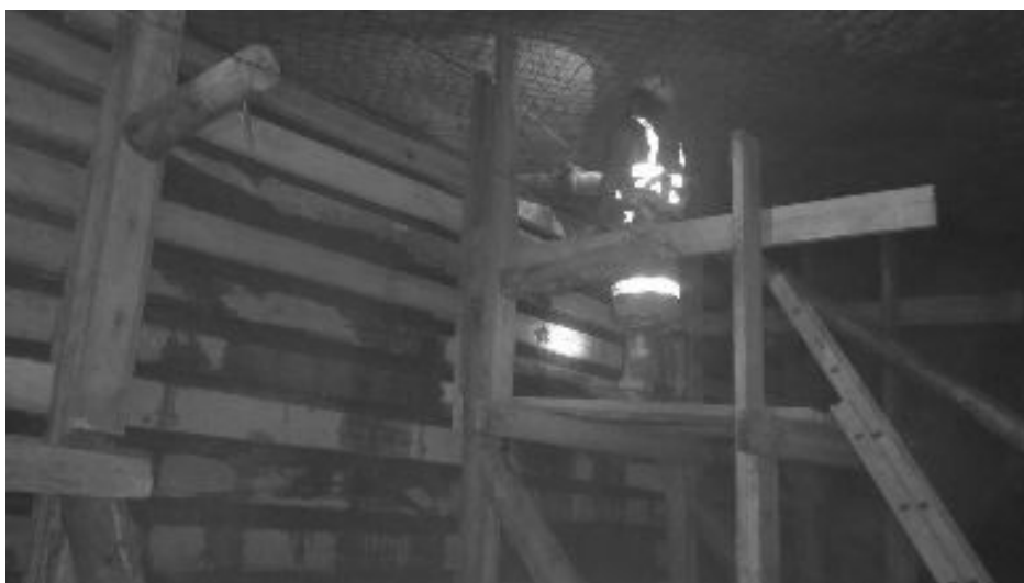
Fotografía N° 2: Aplicación del relleno cementado
