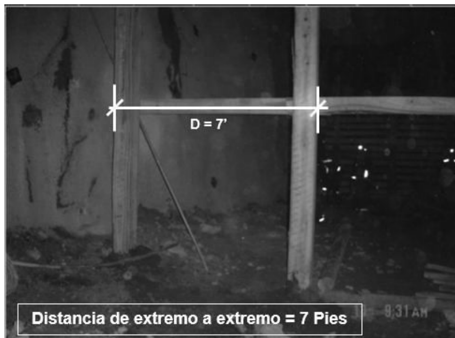
Figura N° 3.5: parado de postes
