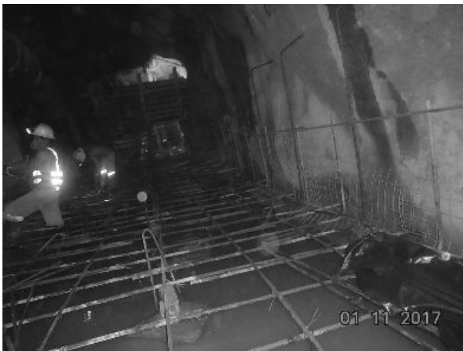
Fotografía N° 1: Preparación del enfierrado para las losas
