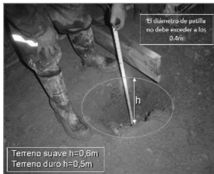
Figura N° 3.3: Picado de patillas
