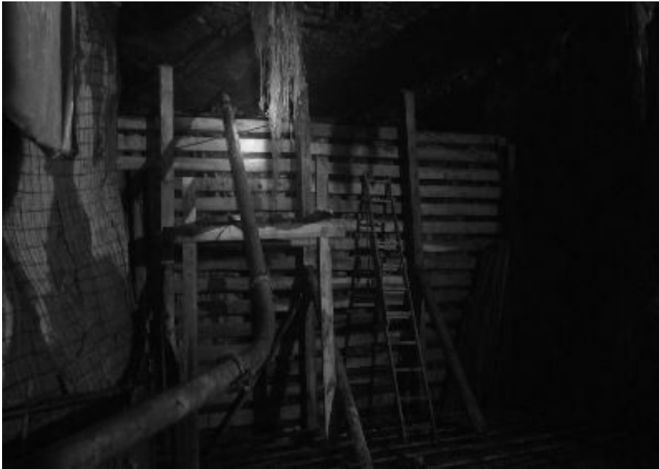
Fotografía N° 6: proceso de bombeo de relleno cementado
