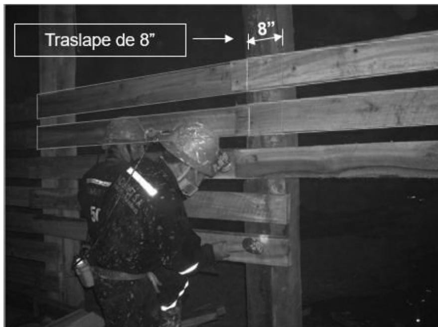
Figura N° 3.6 Enrejado e poste a poste
