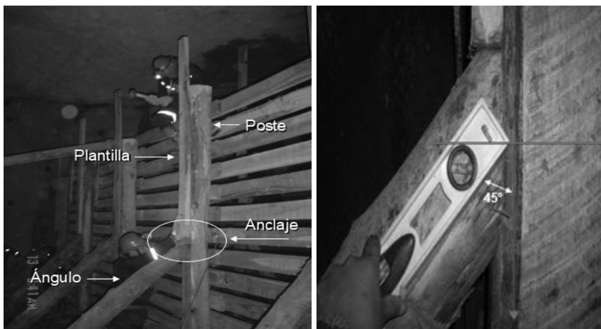
Figura N° 3.8: colocado de patillas de acuerdo a los procedimientos.
