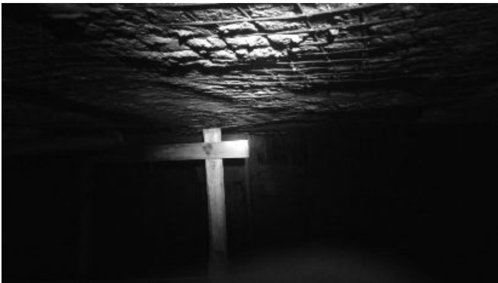
Fotografía N°:7 vista de relleno cementado
