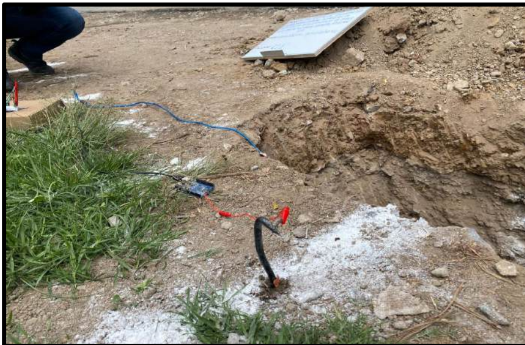
Figura 91 — Registro de aceleraciones aplicando carga
