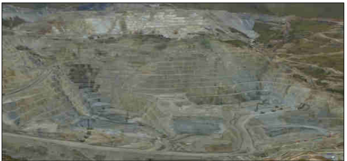
FOTOGRAFIA 2- 5. Caminos Pioneros-Ruta de Camiones
