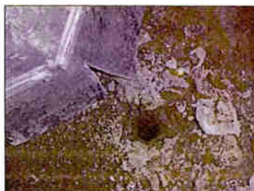
FOTOGRAFÍA 3-7. Orificio de Acceso Perforado Previamente a Través de la Estructura de la Calzada.
