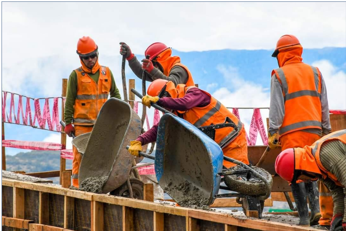
Figura 128 — Trabajos de vaciado de concreto reservorio Crusmocco
