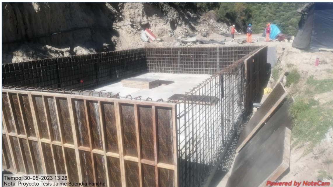
Figura 132 — Trabajos de encofrado reservorio Crusmocco vista posterior
