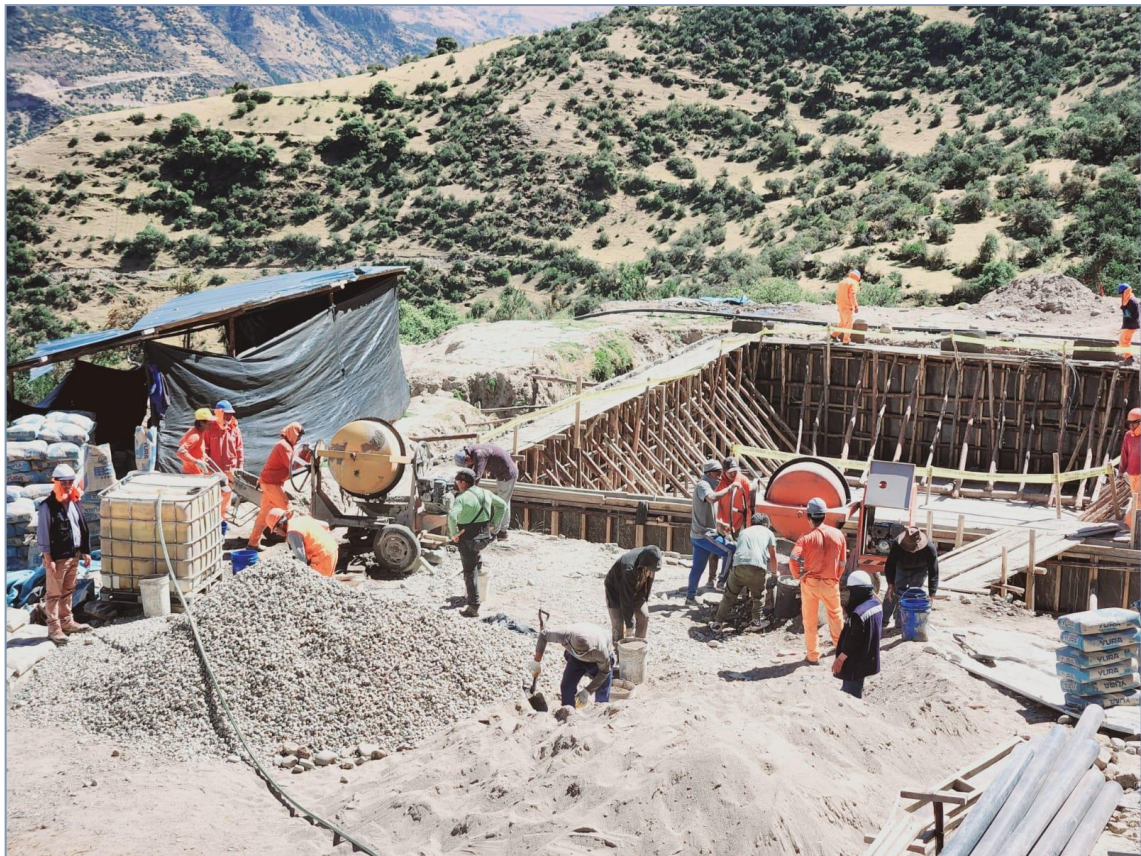
Figura 124 — Trabajos de vaciado de concreto reservorio Ccotoma
