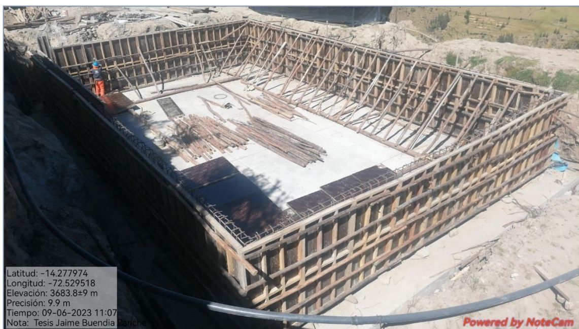
Figura 127 — Trabajos de encofrado reservorio Crusmocco vista superior
