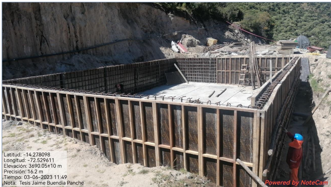
Figura 126 — Trabajos de encofrado reservorio Crusmocco vista lateral
