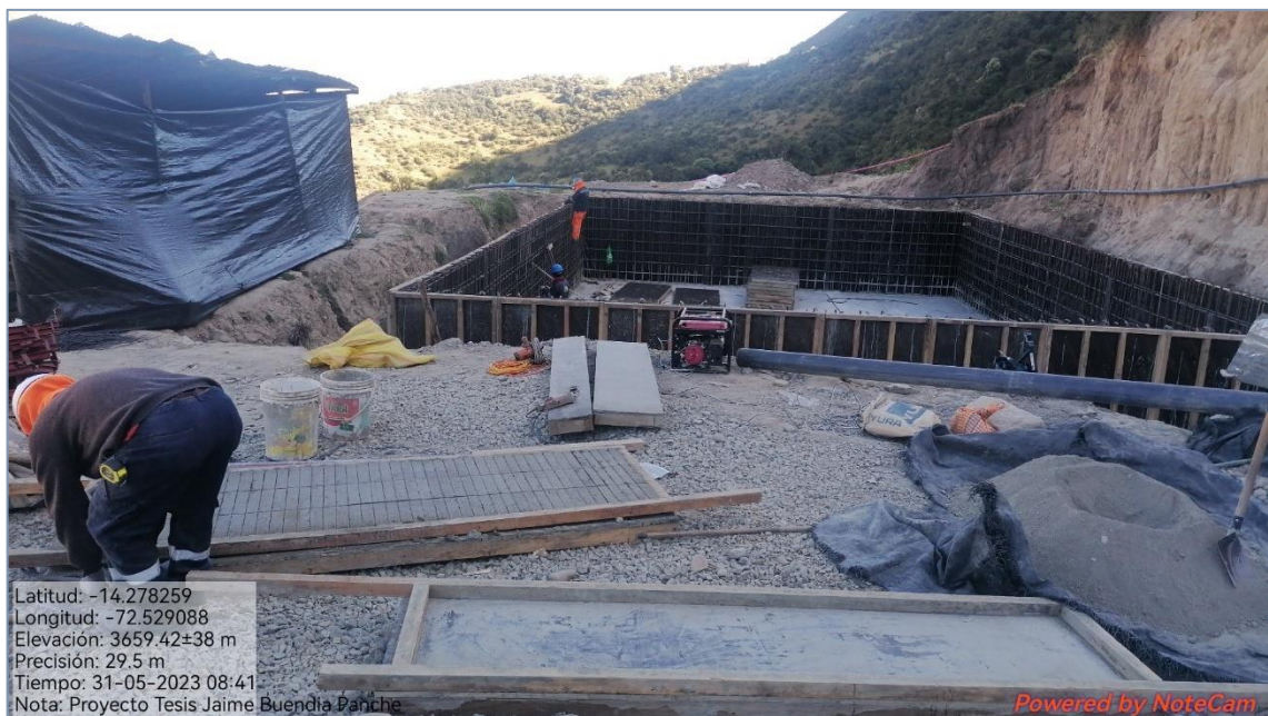
Figura 129 — Trabajos de encofrado reservorio Crusmocco vista posterior
