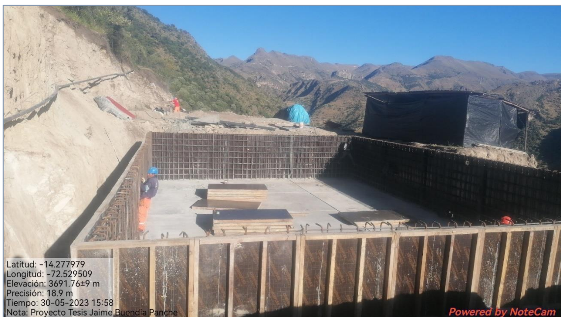
Figura 133 — Trabajos de encofrado reservorio Crusmocco
