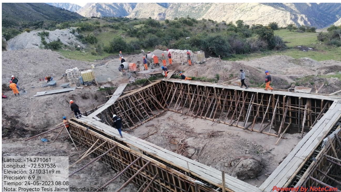
Figura 125 — Trabajos de encofrados reservorio Crusmocco vista lateral
