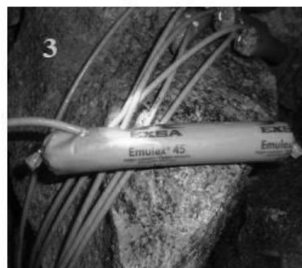
Encebado y carguío de taladros acumulados
