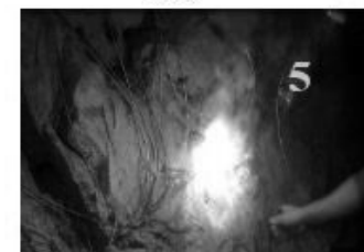
Chispeo y Voladura del Tj 5105-1
