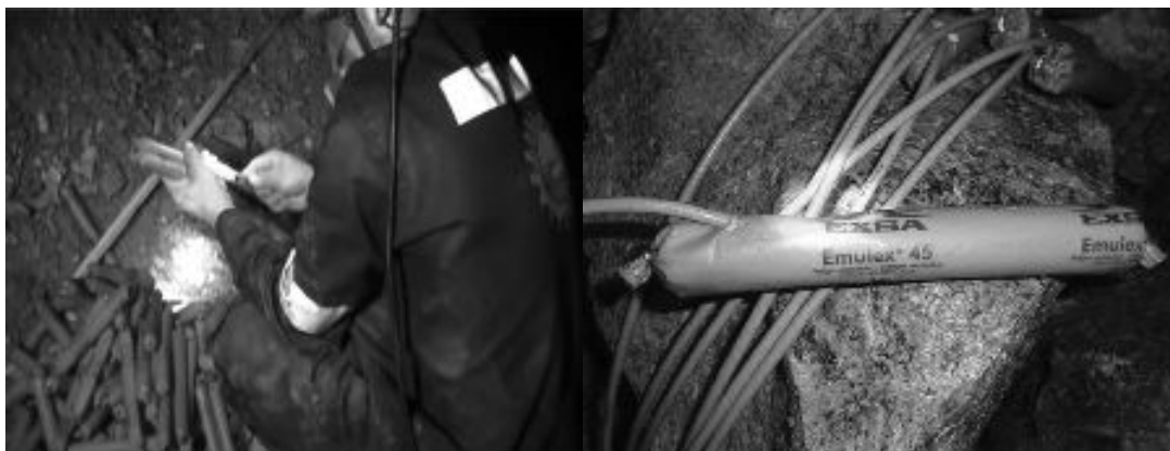
Fotografía 5: Encebado del explosivo Emulex 45% TJ 5105-1 Nv 1700.
