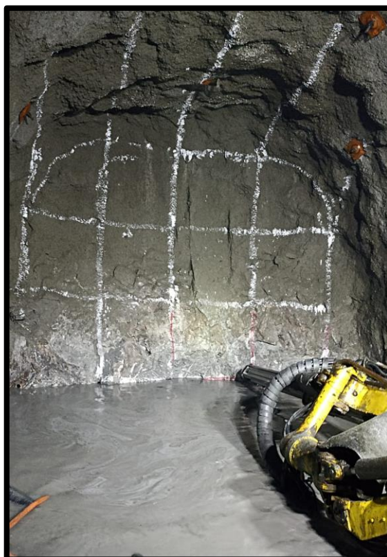
Figura 17 — Diseño de malla Rampa negativa 275
