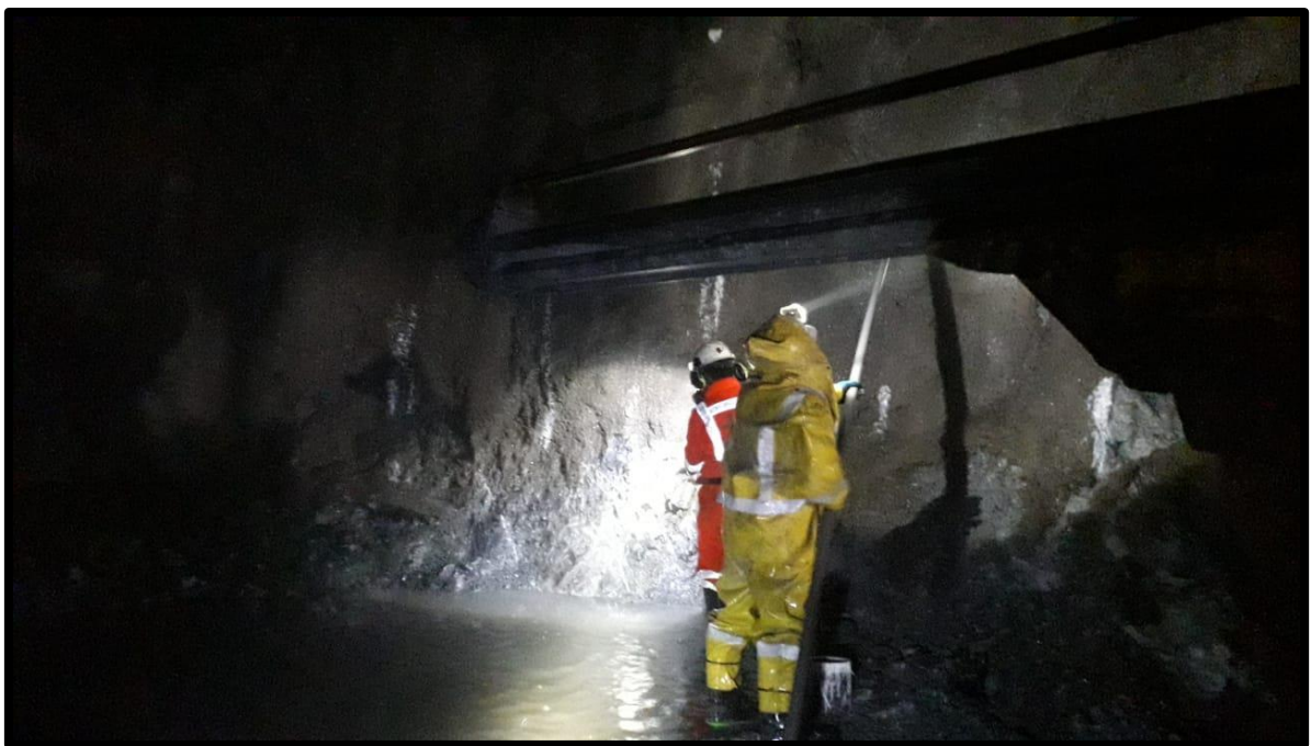
Figura 19 — Inspección de frente
