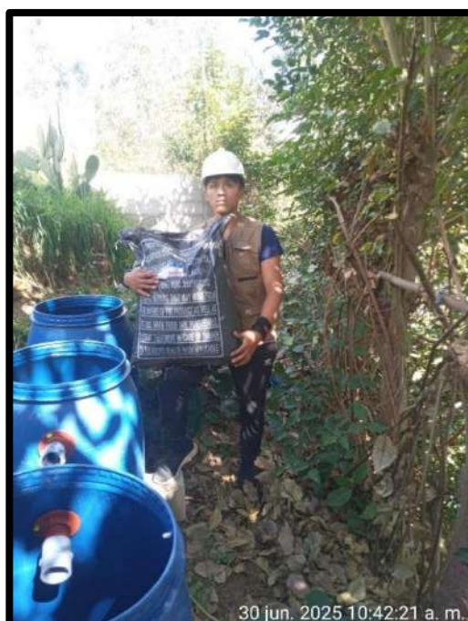
Figura 36 — Incorporación de Carbón Activado en primer contenedor
