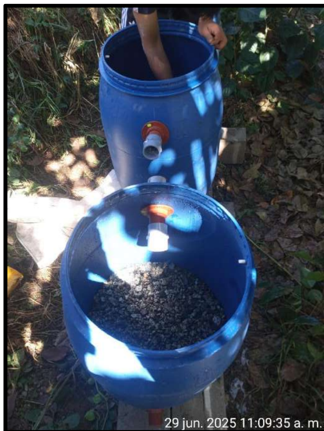
Figura 35 — Construcción de sistema de filtro
