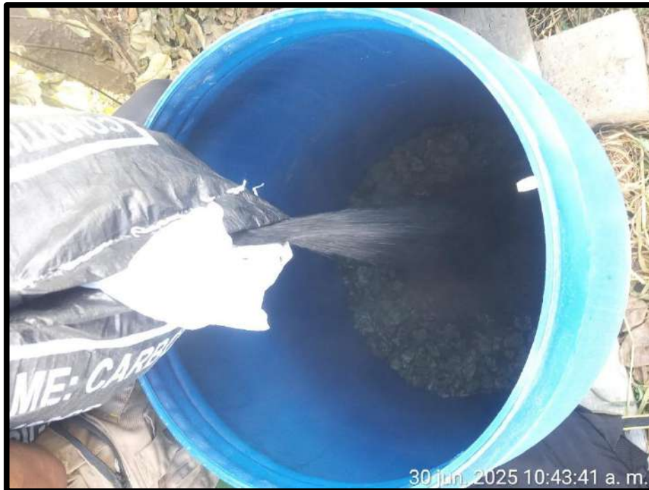
Figura 37 — Incorporación de carbón activado en tercer contenedor
