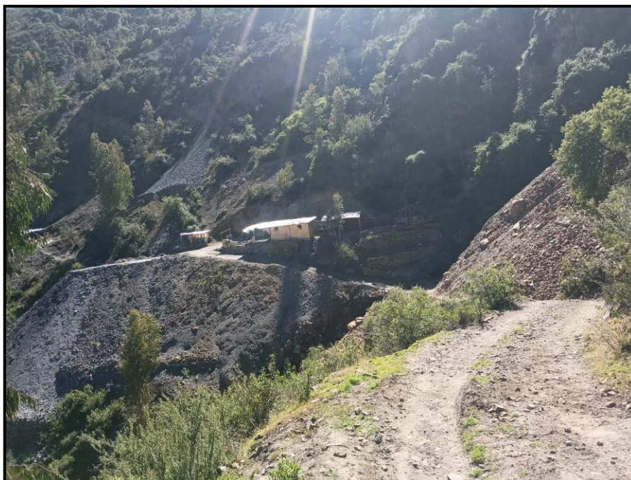
Figura 63 — Vista de labores mineras del distrito de Pachaconas
