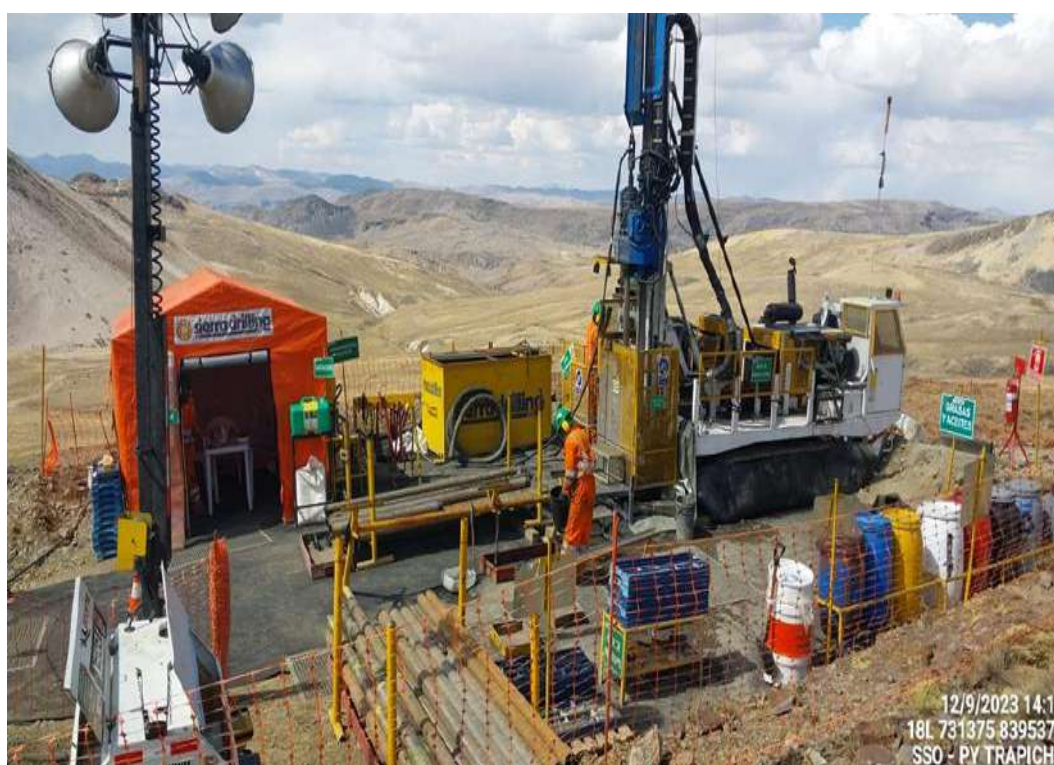
Figura 68 — Perforación diamantina realizado por Sierra Drilling
